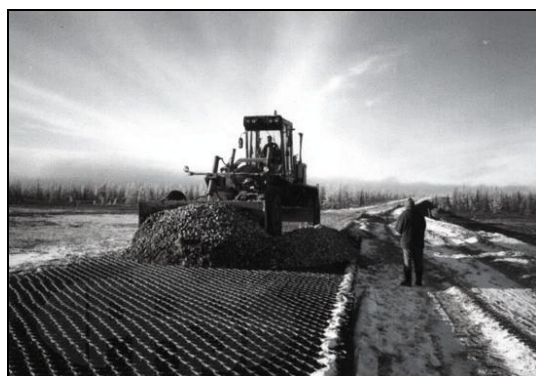
Rys. 8. Zasypywanie kruszywem komórek geosiatki za pomocą ładowarki
